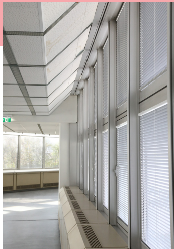
Fensterfront in Raum 1 (EG)
