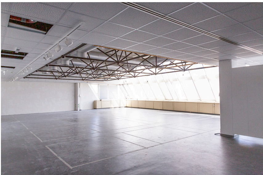
Freihandbibliothek - Scheinwerferleiste, Deckenverstrebungen
