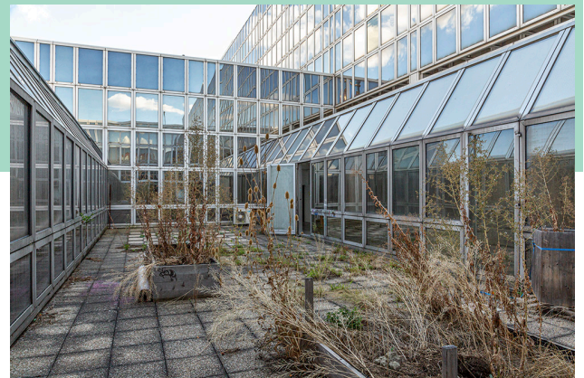
Innenhof - Terrasse mit Betonplatten verlegt
