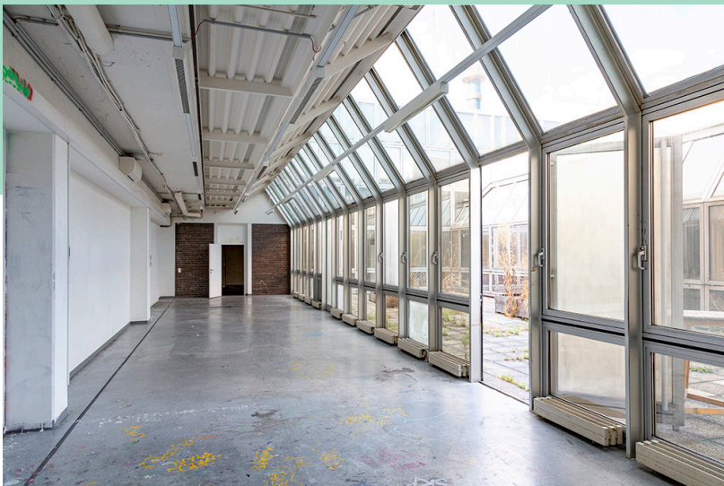
Glasgalerie - Blick Richtung Innenhof
