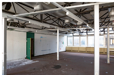
Raum 3 mit Säulen und Deckenverstrebenungen
