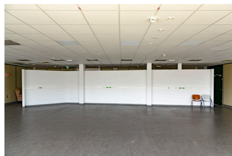
verbaute Trennwand mit Elektroanschlüssen in Raum 1
